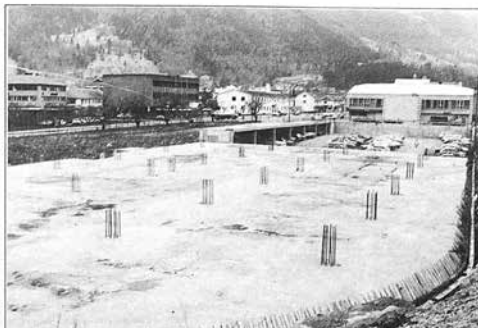
Sogndal Eigedomsselskap A/S har skaffa nok leigetakarar i kulturhuset til at dei no kjem til å gjere eit vedtak om å setje i gang bygginga.
