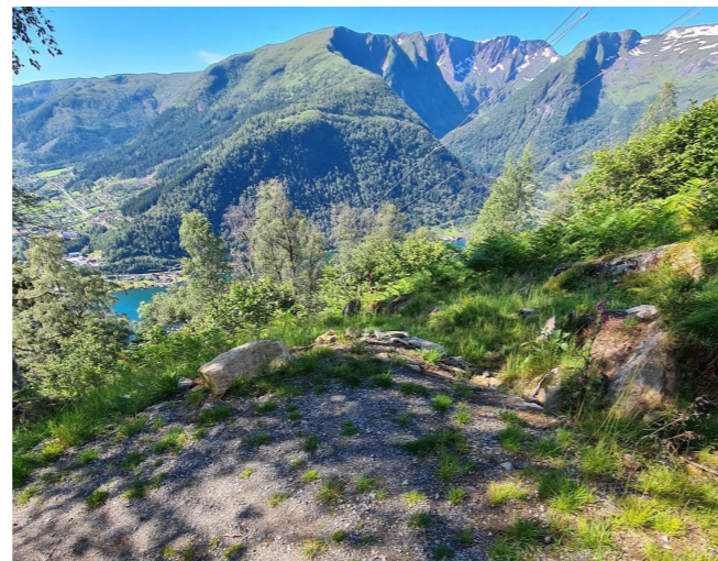
Skarp sving ved Klyvd dagsturhytte, som kan skape farlege situasjonar for hjulbrukarar
