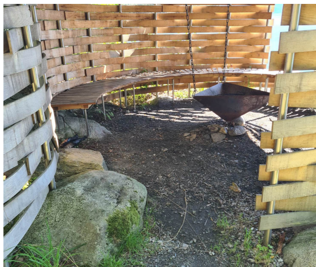
Gapahuk med for smal inngang for rullestolbrukarar
