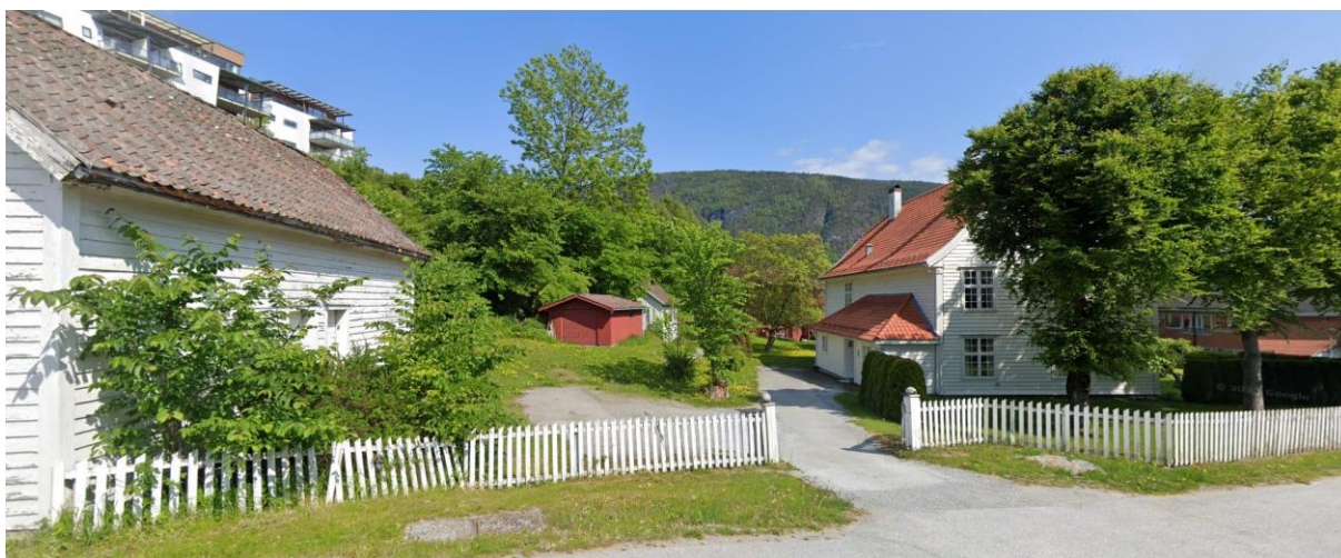
Figur 3-8. Sogndal prestegard, gbnr. 21/181, med vedtaksfreda hovudbygning frå 1836. I kulturmiljøet inngår også stabbur, uthus, garasje og hageanlegg. Det er viktig å finne ny bruk av kulturminna, for å unngå forfall som reduserer den kulturhistoriske verdien og føremålet med fredinga.
