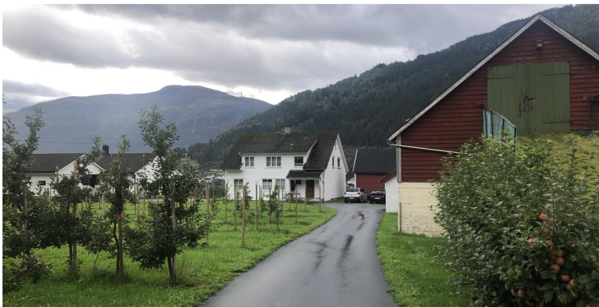
Figur 3-9. Våningshus, driftsbygning og stabbur frå 1800-talet i tunet på Rutlin, gbnr. 22/4.
