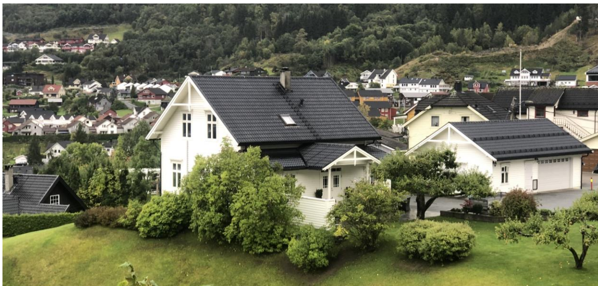
Figur 3-14. Sveitserhus (Trolladalen 8) frå tidleg på 1900-talet med hageanlegg. Tilsvarande ligg bustadhuset på Malthaug (Dalavegen 12A) på ein markert høgde. Dette er viktige identitetsskapande eigedommar i området nedanfor Rutlin, saman med Lemtunet, prestegarden og studentheimen.
