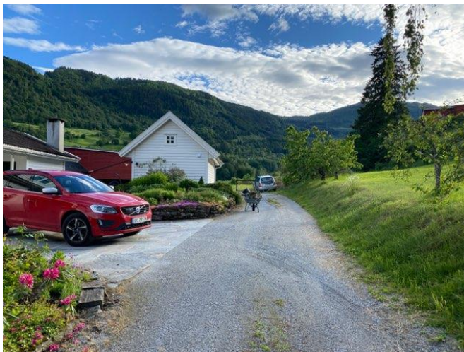
Figur 4 Eksisterande vegareal har ei varierende breidde på 2,5 – 3 meter.
