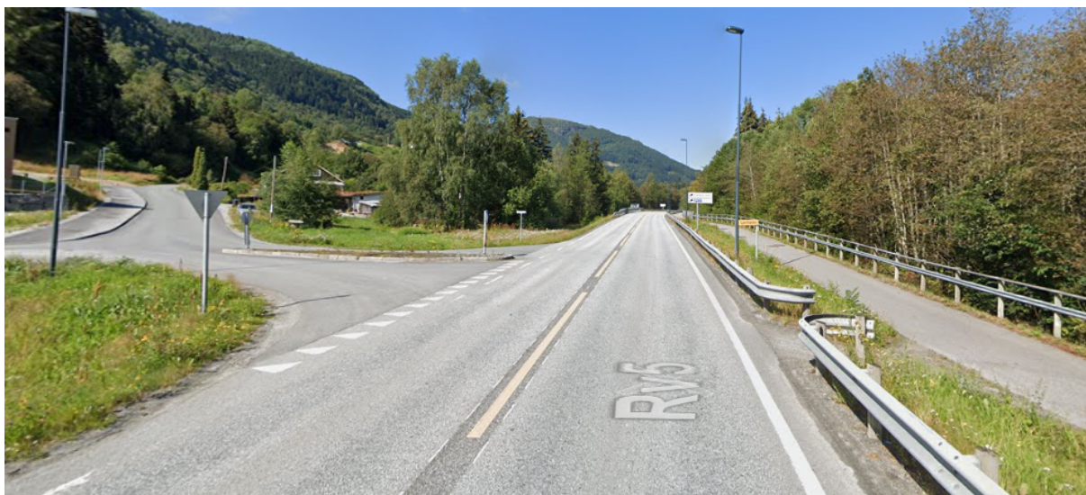
Figur 2: Opning i rekkverket på riksvegen blir stengt som følge av bygging av nytt kryss med Avsølevegen.
