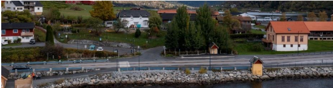
Figur 7-1: Krysset inn til Ronnes Barnehage og Sogndal folkehøgskule (foto: Sogndal kommune/Falkeblikk AS).
