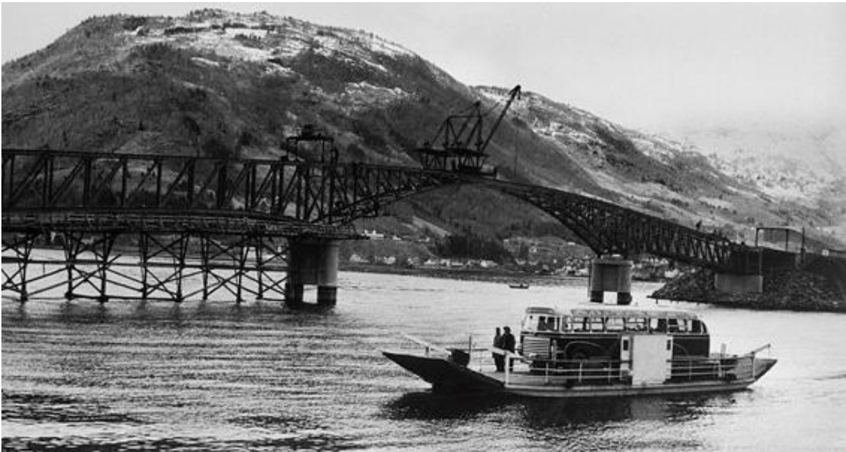
Figur 3-22: I bakgrunnen ser vi Loftesnesbrua, som vart opna i 1958, under bygging. I framgrunnen går ferja som vart nytta til å frakte bilane over sundet. Foto: Fylkesarkivet.
