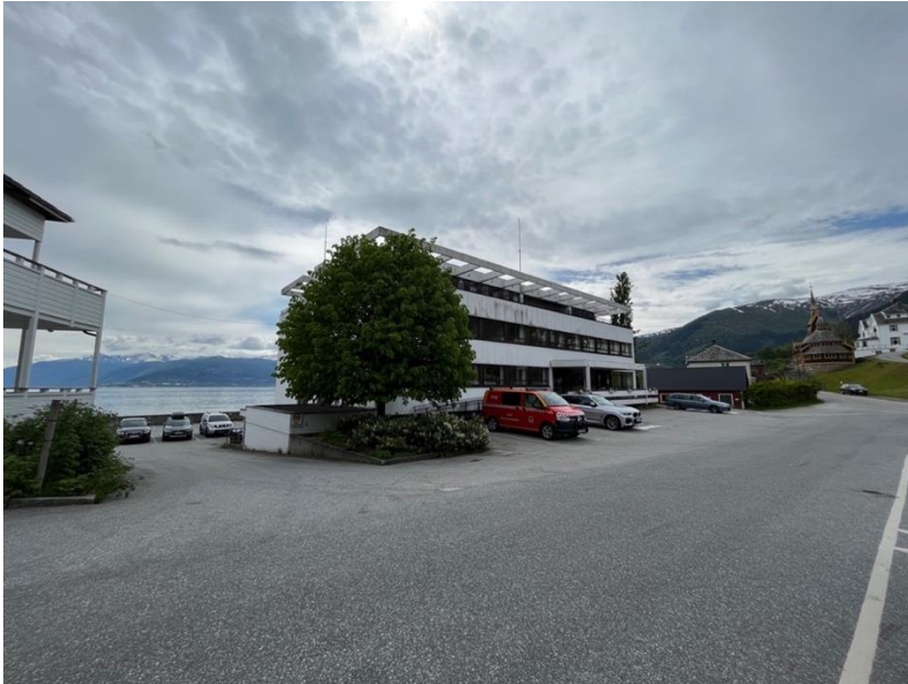
Fig 5. Nærverknad. Bildet viser bygget sett frå Kong Beles veg når ein kjem frå Balestrand sentrum.
